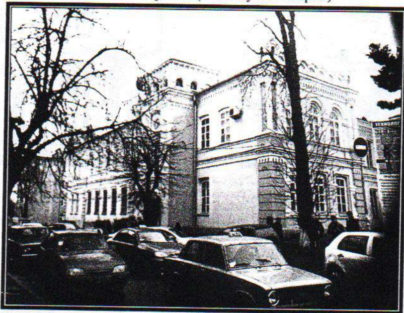
Фото 2 фасад (вид з рогу вул. Соборна і Театральна)
