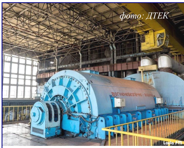
мал.3.1. Переоснащення ГОУ блоку №1 ДТЕК Ладизинська ТЕС
