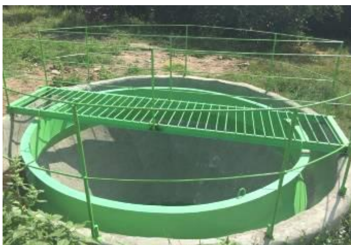
мал.4.5. У 2018 році проведено реконструкцію ОСК м.Ямпіль
