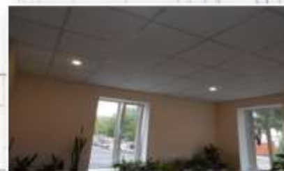
Ремонт стелі районної станції юнних натуралістів -35,0 тис.грн.
