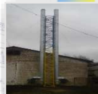
Встановлення труби в КЗ «Чечельницька СЗШ №1» - 130тис.грн.
