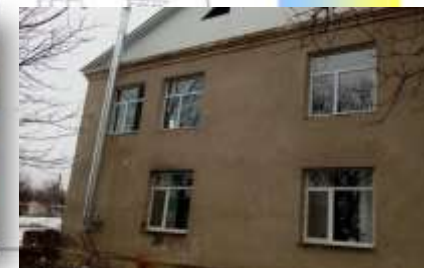
Встановлення вікон та дверей в ДНЗ с. Бондурівка -63,0 тис.грн.
