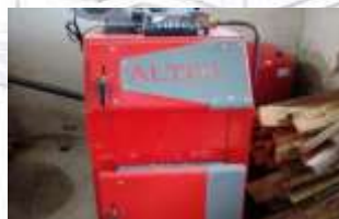
Капітальний ремонт системи опалення ДНЗ с. Бондурівка 291тис грн.
